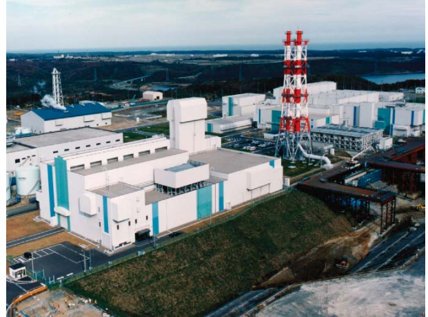
Almacenamiento en Rokkasho-Mura e Instalación de Manejo en Japón
